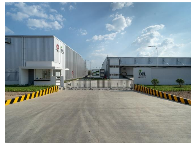
倉庫エントランス
