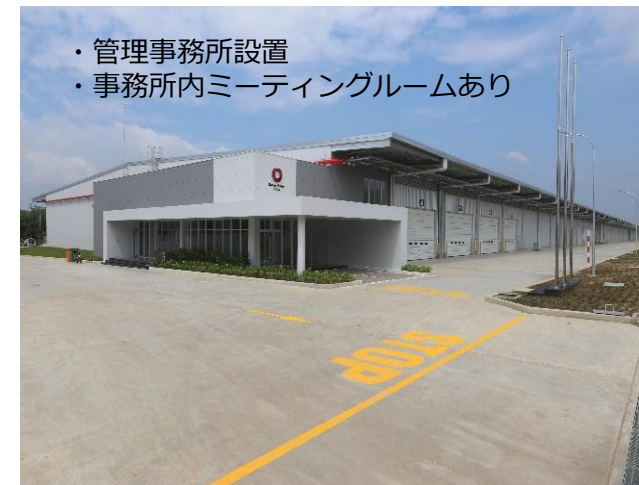
倉庫エントランス 管理事務所
