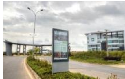
エントランスプラザ
